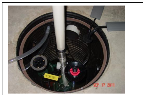
Fig. 16 – Module pentru aspirarea aerului cu infiltrații de radon
