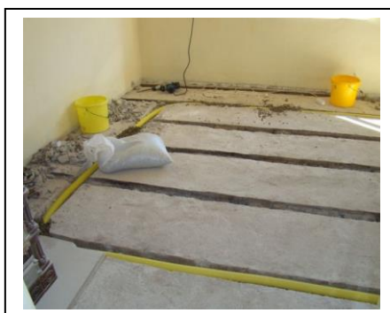
Fig. 9 - Practicarea de șanțuri în șapa unei plăci pe sol, pentru introducerea tubulaturii perforate, pentru absorbția radonului [27]
