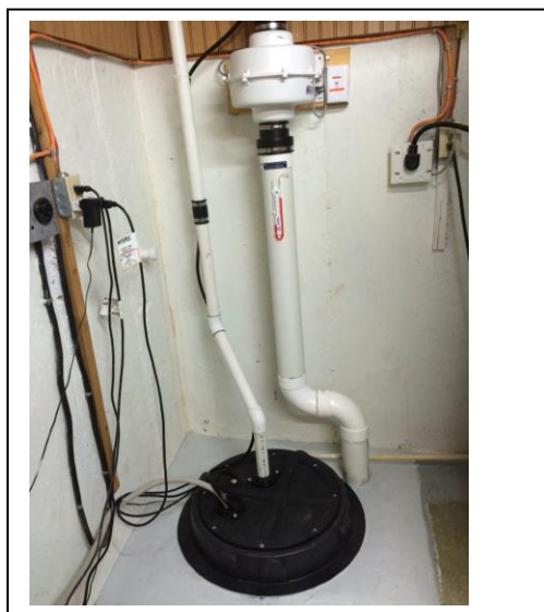
Fig. 16 – Module pentru aspirarea aerului cu infiltrații de radon
