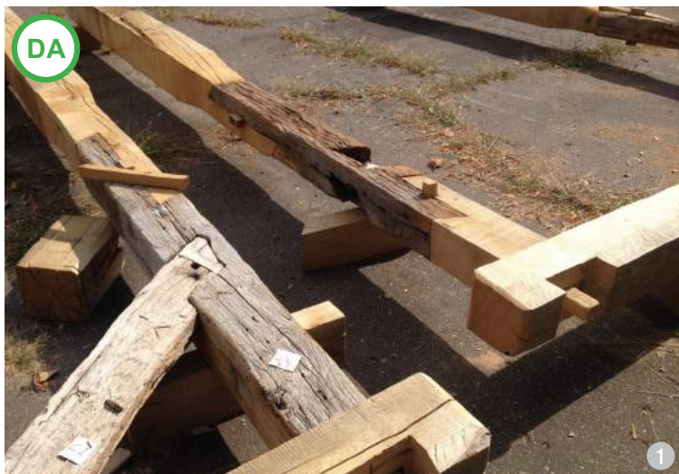
AȘA DA: Cadre tradiționale din lemn în timpul restaurării: un element afectat de degradare nu trebuie înlocuit cu totul. (Grânari, jud. Brașov)
