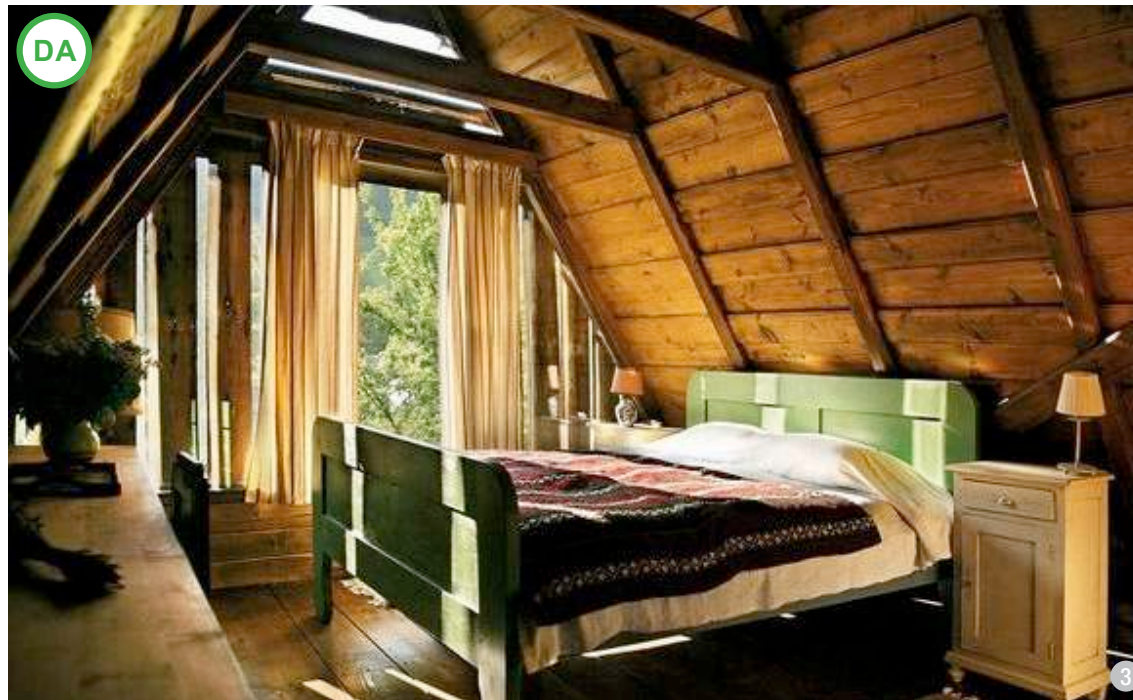
AȘA DA: Pentru construcțiile anexe în care se amenajează spații de locuit mansardate, se pot utiliza procedee precum cel din imagine privind vitrarea întregului fronton, mai ales dacă acesta a fost inițial din lemn. (Copșa Mare, jud. Sibiu)
