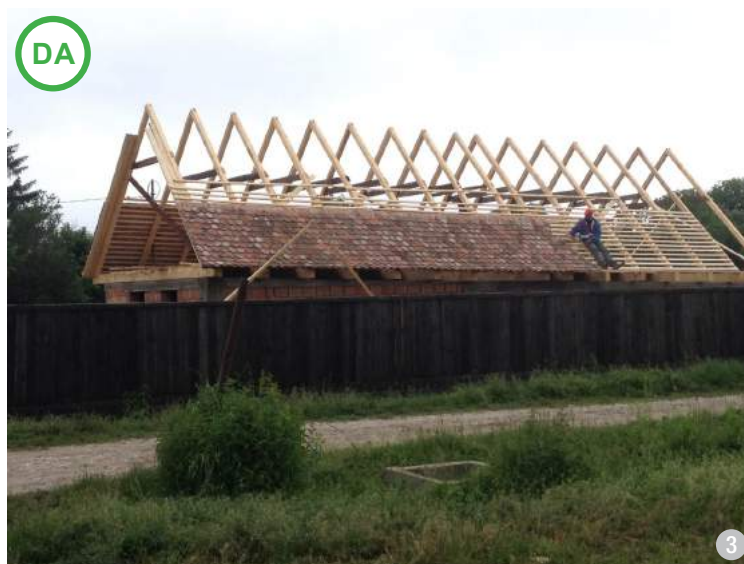
AȘA DA: Exemplul unei șarpante simple, un sistem care se folosește regulat în sudul Transilvaniei. (Viscri, jud. Brașov)
