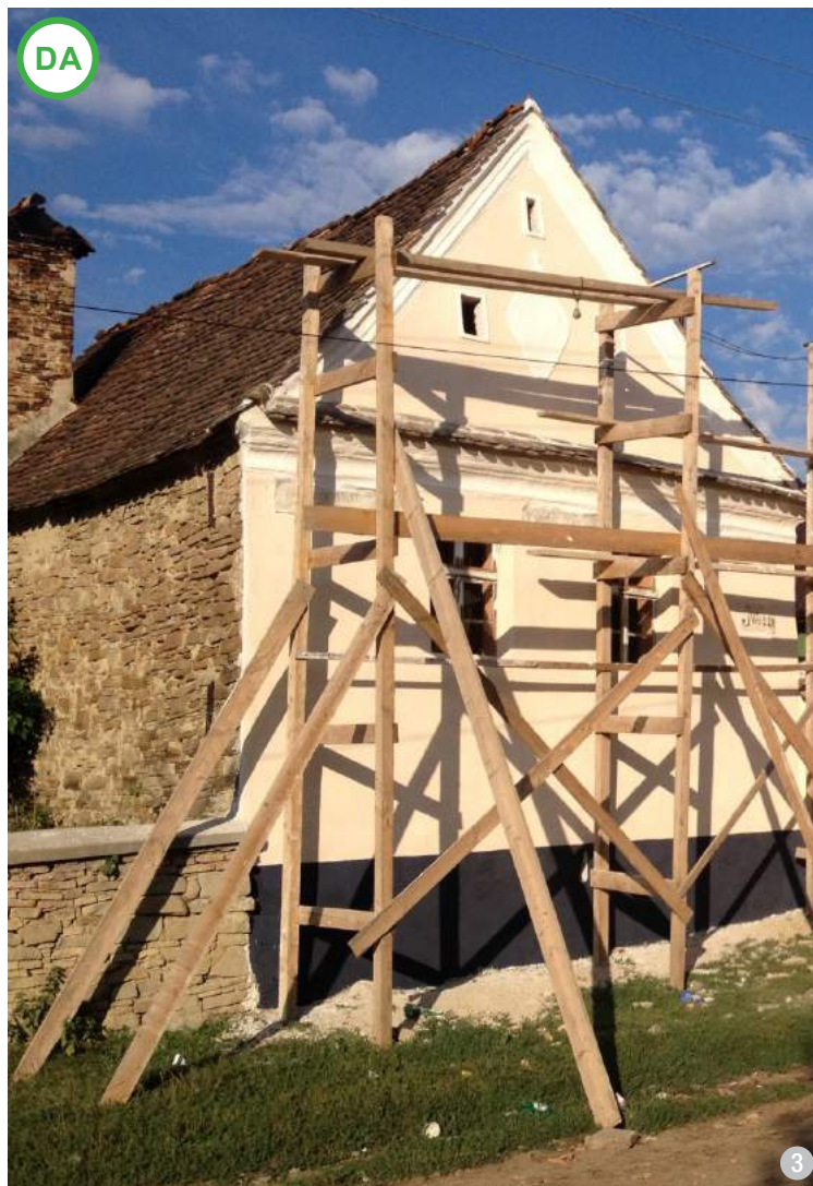
AȘA DA: Zidurile din piatră tencuite cu mortare pe bază de var reprezintă două tipuri de materiale compatibile. (Daia, jud. Mureș)
