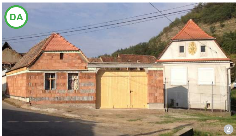
DA AȘA DA: Clădirea nouă realizată din cărămidă cu goluri mari și beton arată că anumite materiale noi pot fi puse în operă, în logica lor, într-un mod care să țină cont de volumetria specific locală. (Richiș, jud. Sibiu)
