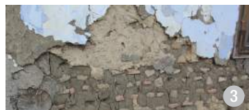
Detaliu de parament al unei case din lemn: tencuială din lut cu armătură din paie și cărămidă. (Grânari, jud. Brașov)
