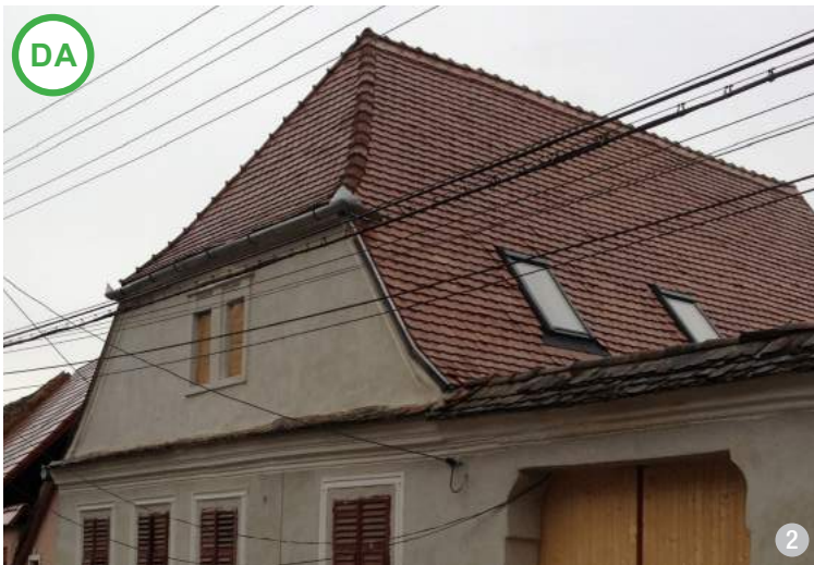
AȘA DA: Amenajarea unor goluri în planul acoperișului aduce cele mai puțin modificări volumetricii acestuia, dar sunt de preferat intervențiile în care construirea de ferestre și lucarne se bazează pe susținerea economiei locale; or, ferestrele de tip Velux nu angrenează într-o formă consistentă meșteșugul local tradițional. (Biertan, jud. Sibiu)
