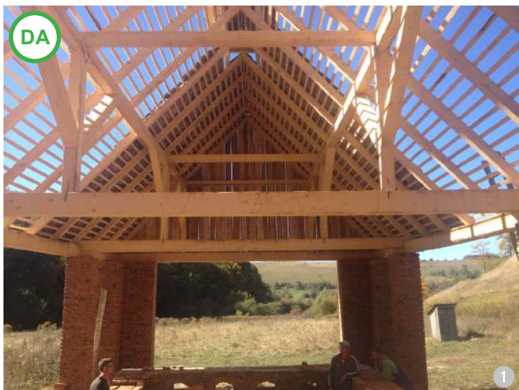
AȘA DA: Șarpanta realizată cu „scaun” specific construcțiilor cu deschidere mare. (Apoș, jud. Sibiu)
