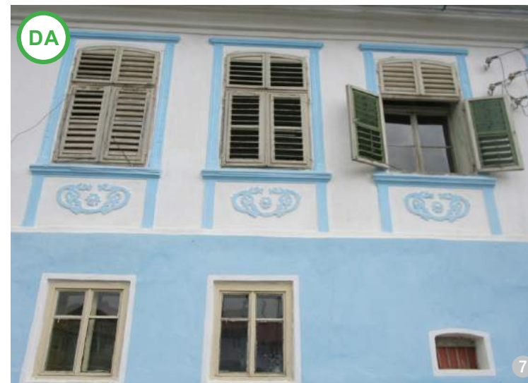
Fereastră cu un strat de geam dublat de un oblon – soluție pentru perioada de vară. În timpul iernii, se schimbă oblonul cu un strat de ferestre, pentru o termoizolare mai bună. (Roadeș, jud. Brașov)
