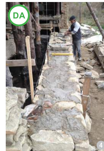
Folosirea pietrei pentru zidurile și fundațiile construcțiilor noi este optimă în zone cu umiditate mare. (Daia, jud. Mureș)
