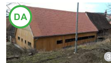
AȘA DA: Finisajul cu lambru de lemn după dimensiunile locale este varianta optimă pentru clădirile de orice dimensiune. (Roadeș, jud. Brașov)
