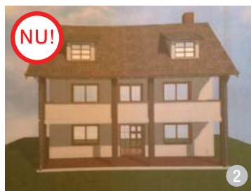
AȘA NU: Proporția ferestrelor este nehotărâtă și nu respectă specificul local; împărțirea canaturilor este impersonală, iar ritmul golurilor nu are nicio legătură cu specificul local. (Șaeș, jud. Mureș)
