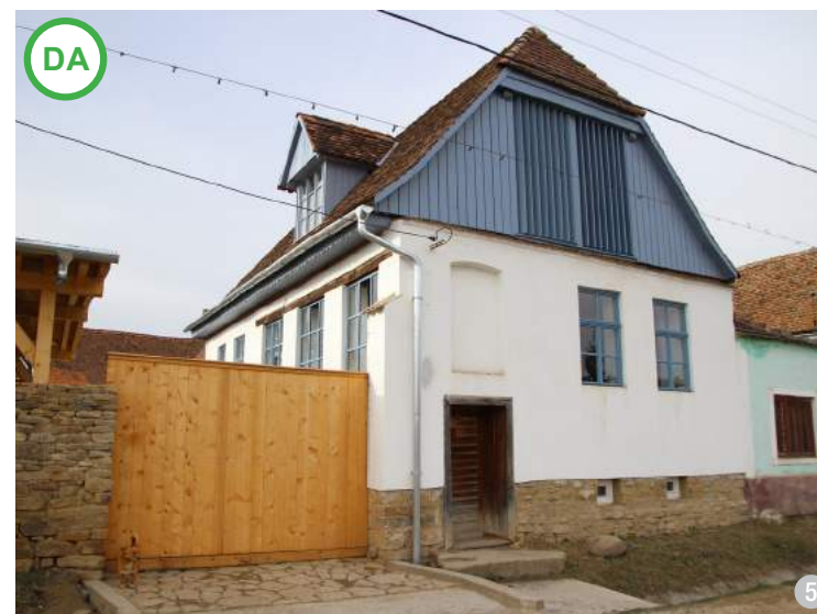
ASA DA: Construirea unui acoperiș nou peste o clădire aflată în ruină propune un concept interesant privind intervenția contemporană vizibilă asupra unei clădiri tradiționale. În mod normal, modificarea unui acoperiș existent în acest fel ar fi contraindicată pentru clădirile tradiționale (Cobor, jud. Brașov)
