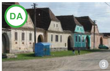
Acoperiș în două ape cu pinion teșit care apare preponderent în zona Brașovului, dar și pe întreg teritoriul zonei de sud a Transilvaniei. (Valchid, jud. Sibiu)
