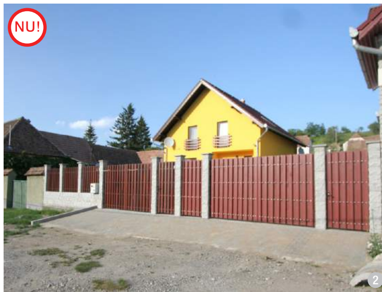
AȘA NU: Gardurile din lemn trebuie să indice specificul local. Dimensiunea elementelor de gard din imagine și pasul lor, forma și prinderile sunt nespecifice zonei de sud a Transilvaniei. (Apold, jud. Mureș)
