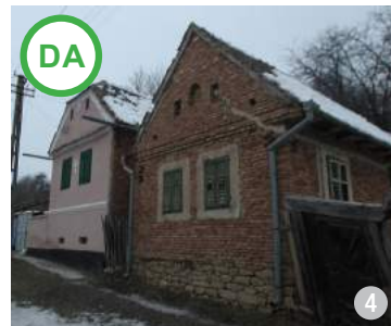
Construcție cu fundație de piatră și pereți din cărămidă (Ghijasa de Jos, jud. Sibiu)
