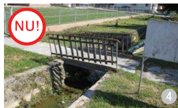
ASA NU: Podeț din beton și metal
