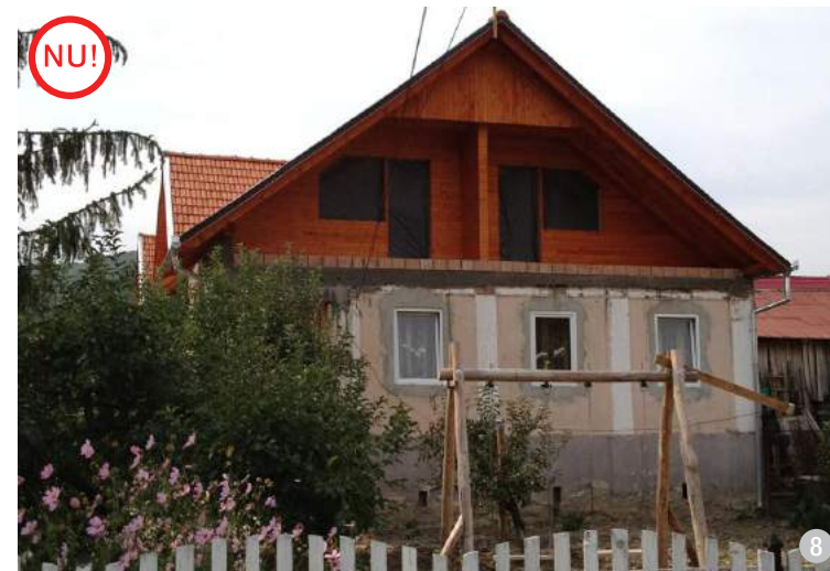
AȘA NU: Nu se acceptă amplasarea logiei și a balconului către stradă și cu atât mai puțin distrugerea frontonului și a decorațiilor pentru realizarea intervenției. (Șaeș, jud. Mureș)
