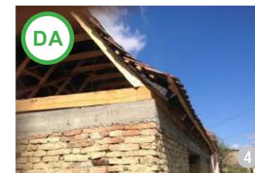
AȘA DA: Soluția sistemului constructiv de la nivelul șarpantei contribuie hotărâtor la forma finală a clădirii. Soluția cu aruncătoare reprezintă un element important de specific local. (Copșa Mare, jud. Sibiu)
