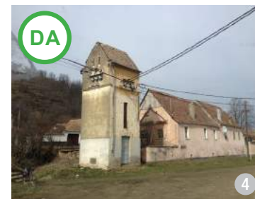
AȘADA: Stație electrică de transformare, care prin volumetrie, finisaje și culoare se încadrează în specificul local (Richiș, jud. Sibiu)
