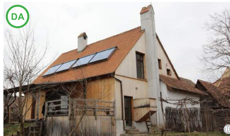
AȘA DA: Amplasarea panourilor generatoare de energie nu va depăși 15 % din suprafața învelitorii. (Viscri, jud. Brașov)
