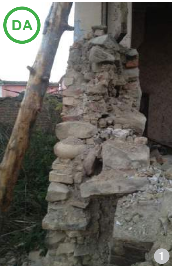
Detaliu de compunere a peretelui: două rânduri de piatră separate de un strat de 10 cm de pământ galben și cărămidă cu rol de termoizolație. (Daia, jud. Mureș)
