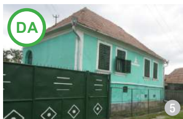
Acoperiș în patru ape specific caselor românești construite după 1920, care apar pe întreg teritoriul de sud al Transilvaniei. (Vecerd, jud. Sibiu)
