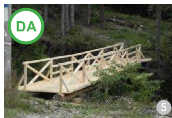
ASA DA: Exemplu de podeț nou de lemn
