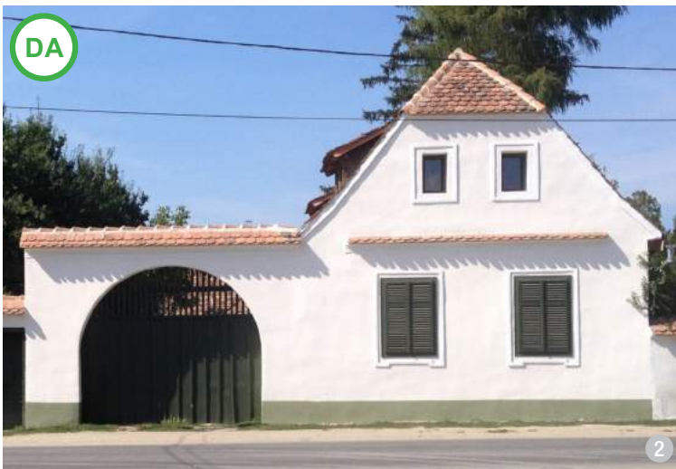
AȘA DA: Amplasarea ferestrelor în găurile de aerisire a podului nu modifică cu nimic aspectul general. (Cincșor, jud. Brașov)
