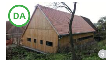
AȘA DA: Pentru construcții cu funcțiuni industriale cu deschideri mari se pot folosi sisteme structurale combinate, atât metal, cât și lemn, pentru a permite utilizarea unor materiale locale pentru finisaje și învelitori precum țigla și lambrul (poza sus: interior/poza jos: exterior). (Rodeș, jud. Brașov)
