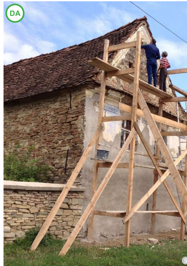
Pereți masivi din piatră, atât la nivelul demisolului, cât și la cel al parterului. (Daia, jud. Mureș)
