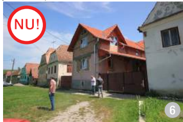
AȘA NU: Nu se recomandă complicarea soluției de acoperire. Iluminatul mansardei poate fi realizat într-un mod mai elegant. (Șaeș, jud. Mureș)
