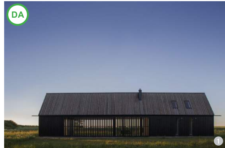
ASA DA: Necesitatea de lumină poate constitui un factor decisiv în arhitectura fațadei. Pereții vitraji pot fi dublați de un element de umbrire din lemn, care trimite la detaliile de închidere ale construcțiilor tradiționale.
