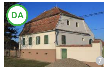
Acoperiș cu rupere de pantă, specific arhitecturii cu influențe baroce prezente pe întreg teritoriul de sud al Transilvaniei. În general, acesta a fost folosit la clădirile mai importante: clădiri administrative, conace, școli, cămine, mori, case parohiale, dar și case de locuit pentru persoane cu un statut social mai ridicat. Nu se recomandă preluarea acestui tip de șarpantă pentru construcții noi decât în cazuri bine argumentate. (Dealul Frumos, jud. Sibiu)
