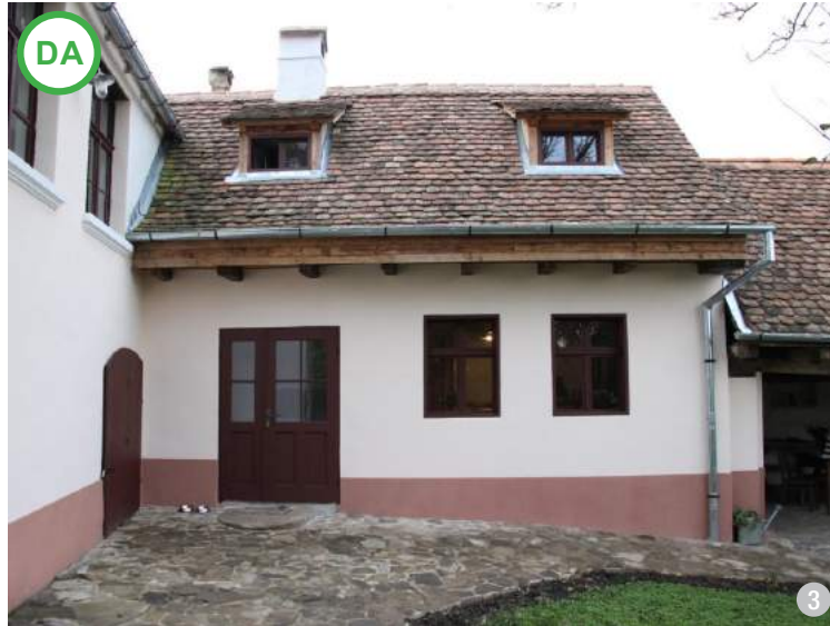
AȘA DA: Micile lucarne într-o singură pantă, amenajate în mansarda unei clădiri secundare, pot aduce suficientă lumină pentru spații precum dormitoare, băi etc. Tipul de lucarnă cu o singură pantă aduce aminte de golurile de intrare în pod și pot avea dimensiuni consistente. Acest tip de lucarnă poate fi folosit și la casa principală, cu condiția ca dimensiunea lor să rămână între niște valori decente, mai mici decât la cele de la anexe, în funcție de gabaritul clădirii. În general, se recomandă ca acestea să se încadreze într-un dreptunghi de 60 x 80 cm pentru casele tradiționale. (Veseud, jud. Sibiu)
