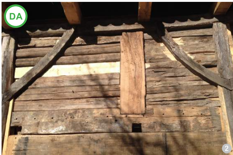
AȘA DA: Intervenție de reabilitare a unui perete din lemn în care s-au păstrat majoritatea elementelor originale. (Grânari, jud. Brașov)
