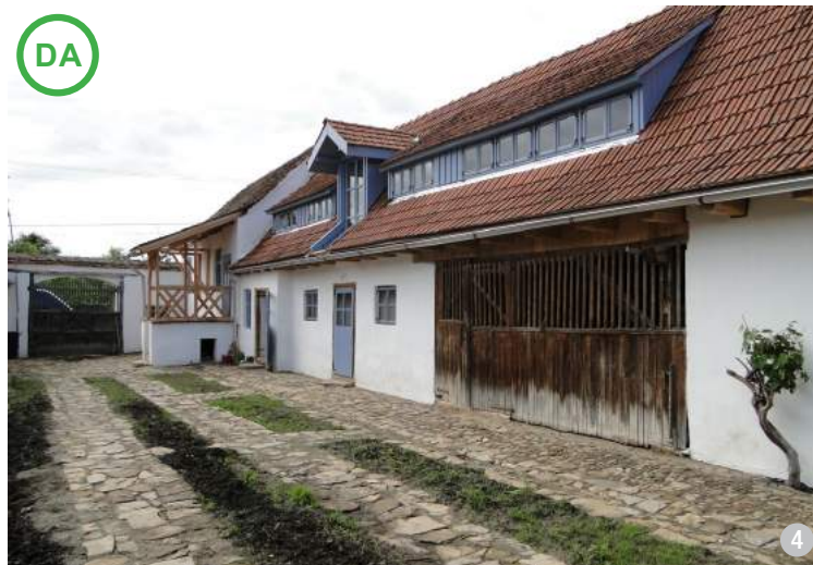
AȘA DA: Lucarna prelungită într-o singură apă precum cea din imagine e o soluție viabilă de iluminare a mansardei. Lucarna centrală în două ape este specifică regiunii Brașovului și nu se recomandă folosirea ei în zona Sibiului sau a Sighișoarei (Cobor, jud. Brașov)
