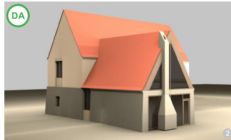
AȘA DA: Construcție nouă. Forma acoperișului respectă specificul local al zonelor cu pantă între 50-55%
