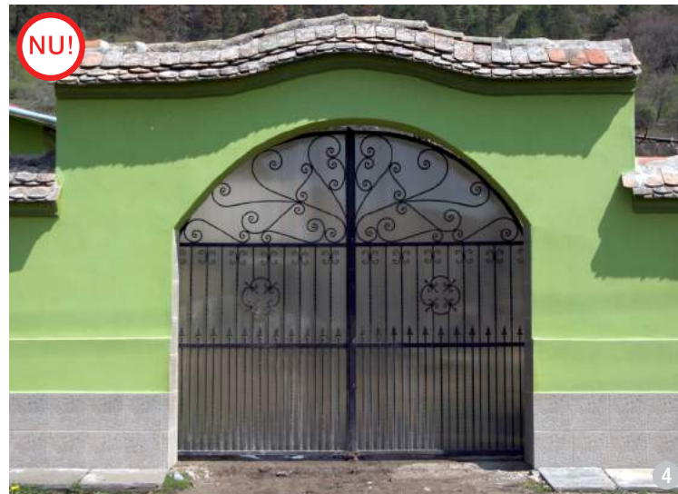
AȘA NU: Înlocuirea porții din lemn cu una din PVC este strict interzisă. Aceasta din urmă este inadecvată din punct de vedere estetic, zomotoasă și nu asigură intimitate, din cauza transparenței materialului. (Iacobeni, jud. Sibiu)
