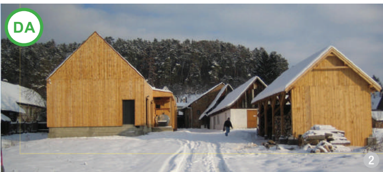
AȘA DA: Acoperișul respectă panta minimă de 45 % a construcțiilor din vatra satului. (Saschiz, jud. Mureș)
