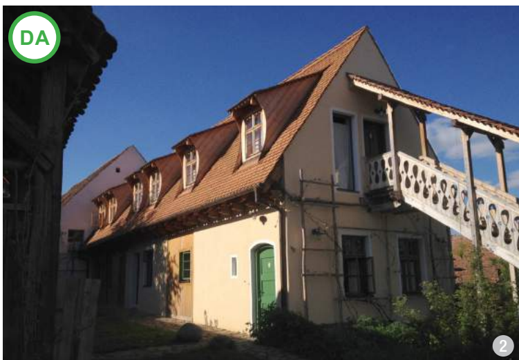
AȘA DA: Amenajarea unor goluri în frontonul din spate poate fi o soluție care nu modifică volumetria clădirii. Se recomandă atenție la posibila existență a unor inscripții sau decorații valoroase; în acest caz, nu se recomandă decuparea golului. (Viscri, jud. Brașov)
