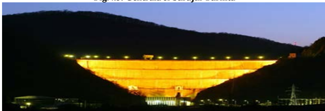
Fig.4.9. Centrala si barajul Tarnita
