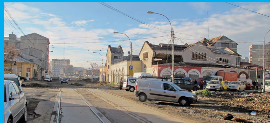
Hala Matache înainte de demolare, București, 2012
